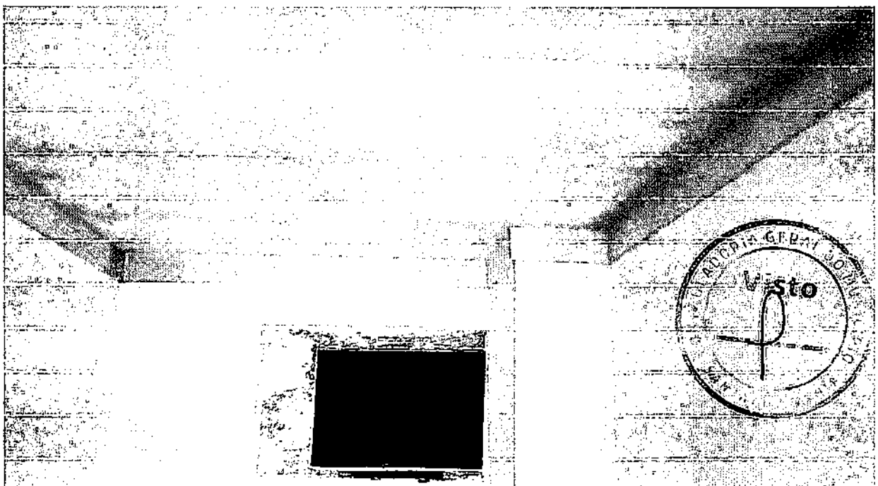
FOTO 43 - ACABAMENTOS PARA FORRO (MOLDURA DE GESSO). AF_05/2017
