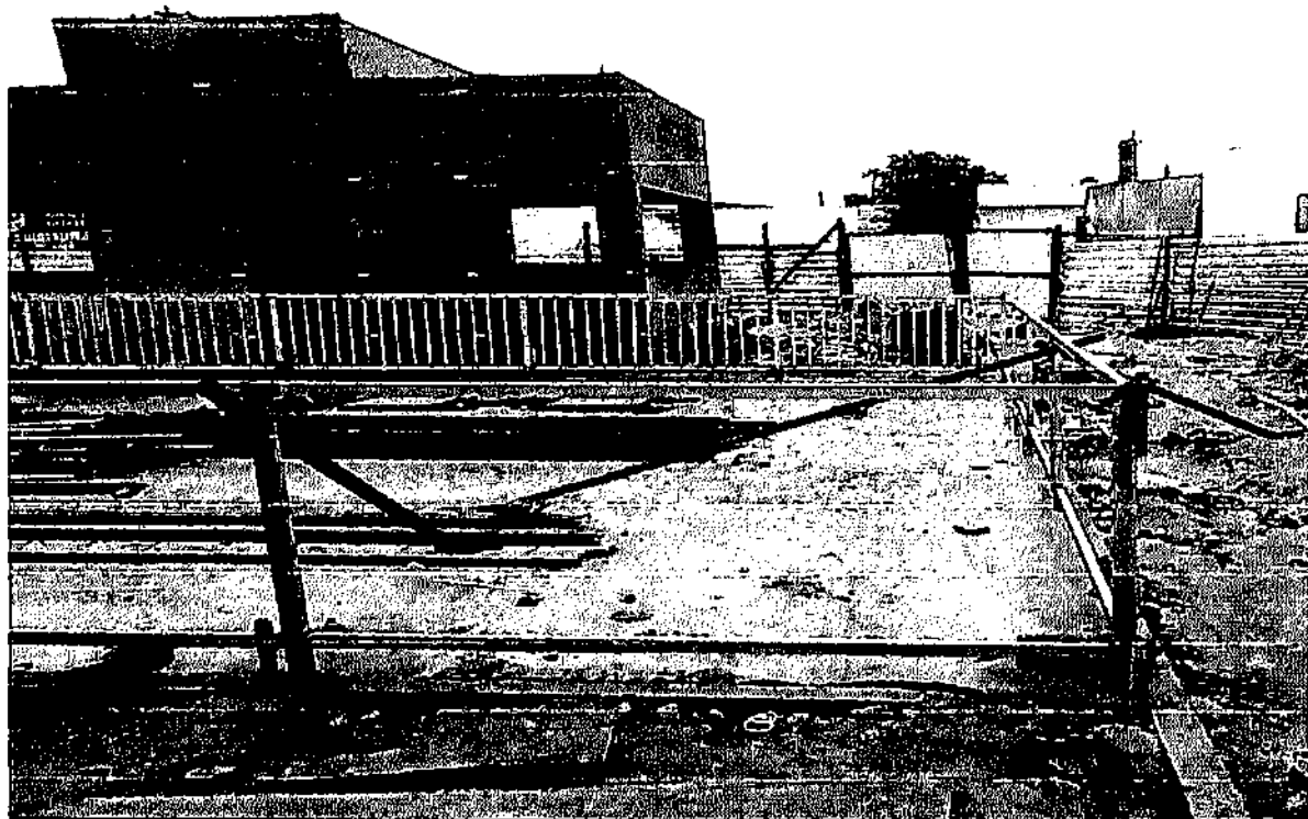
FOTO 91 - GUARDA-CORPO EM TUBO DE AÇO GALVANIZADO (H=100CM), COM BARRAS SUPERIOR, INFERIOR E VERTICAIS A CADA 3.00M (1.1/2") E BARRA VERTICAIS QUADRADA (1/2") A CADA 12CM - REV 01
