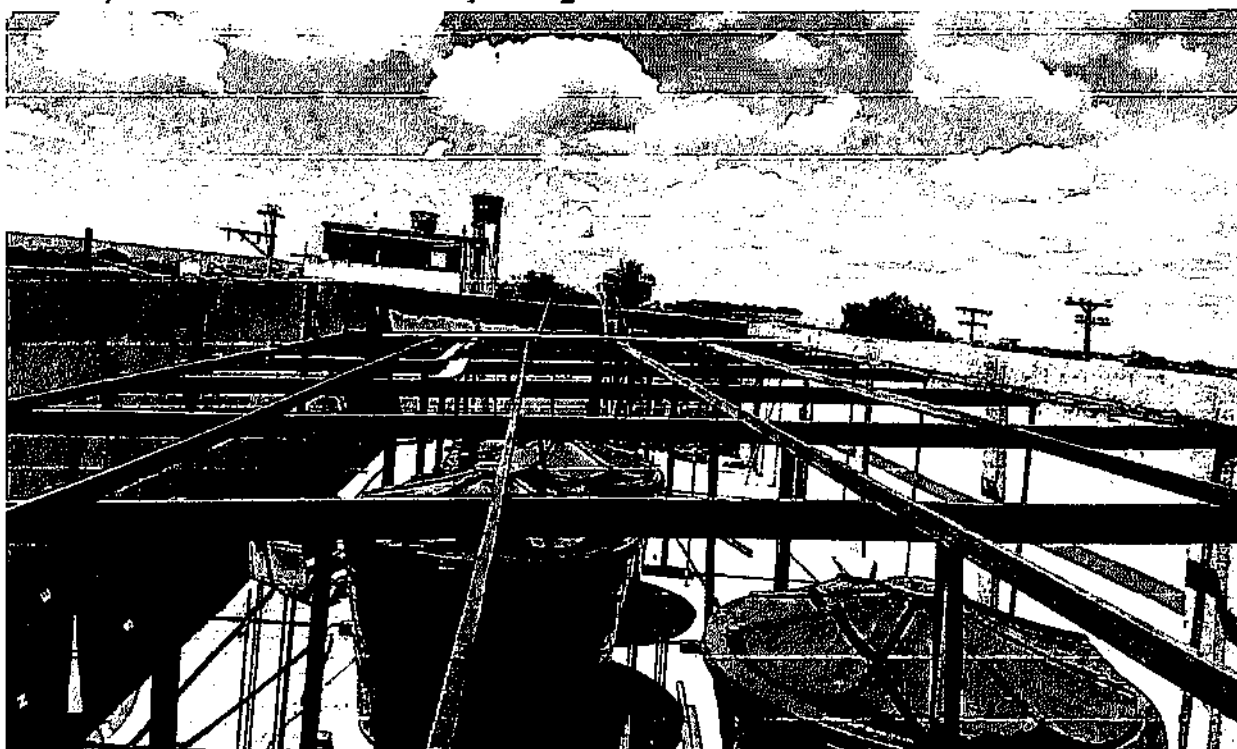
FOTO 77 - CAIXA D'ÁGUA EM POLIETILENO, 3000 LITROS (INCLUSOS TUBOS, CONEXÕES E TORNEIRA DE BÓIA) - FORNECIMENTO E INSTALAÇÃO. AF_06/2021
