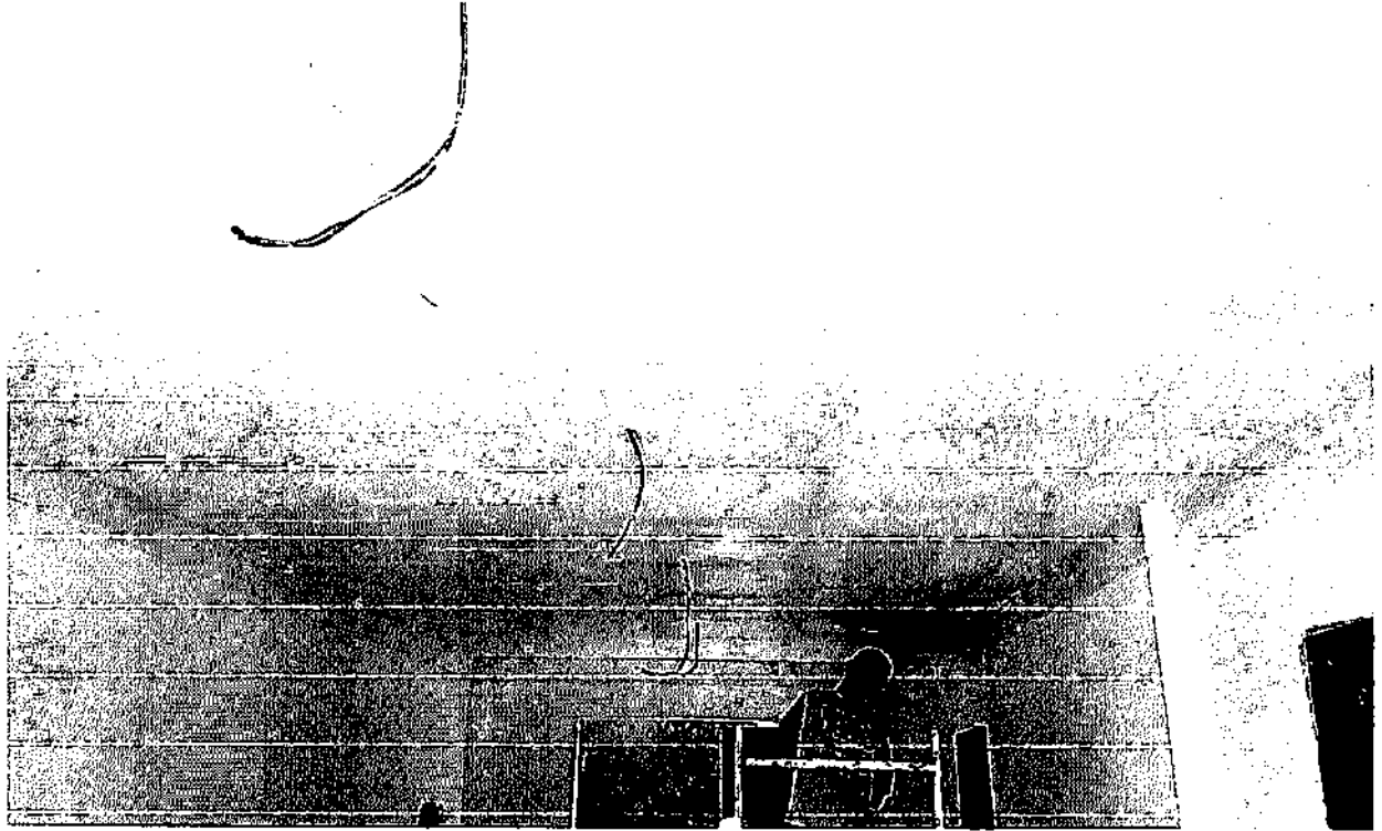
FOTO 39 - FORRO EM PLACAS DE GESSO, PARA AMBIENTES COMERCIAIS. AF_05/2017_P
