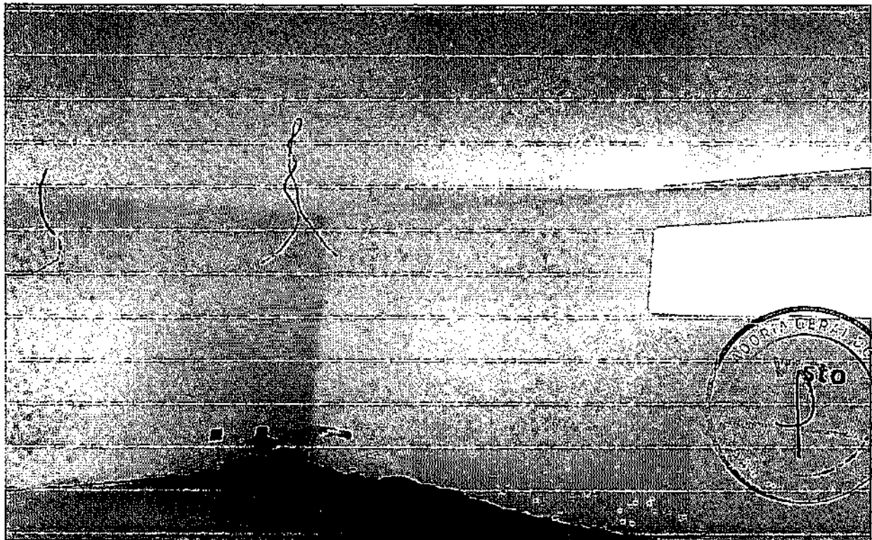
FOTO 47 - EMASSAMENTO COM MASSA A OLEO, DUAS DEMAS
