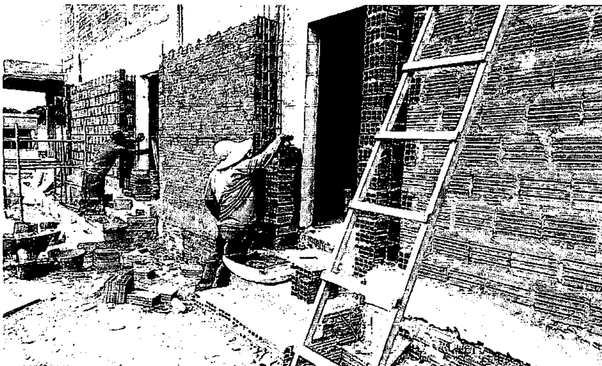
FOTO 97 - ALVENARIA DE VEDAÇÃO DE BLOCOS CERÂMICOS FURADOS NA HORIZONTAL DE 9X19X19 CM (ESPESSURA 9 CM) E ARGAMASSA DE ASSENTAMENTO COM PREPARO EM BETONEIRA. AF_12/2021.
