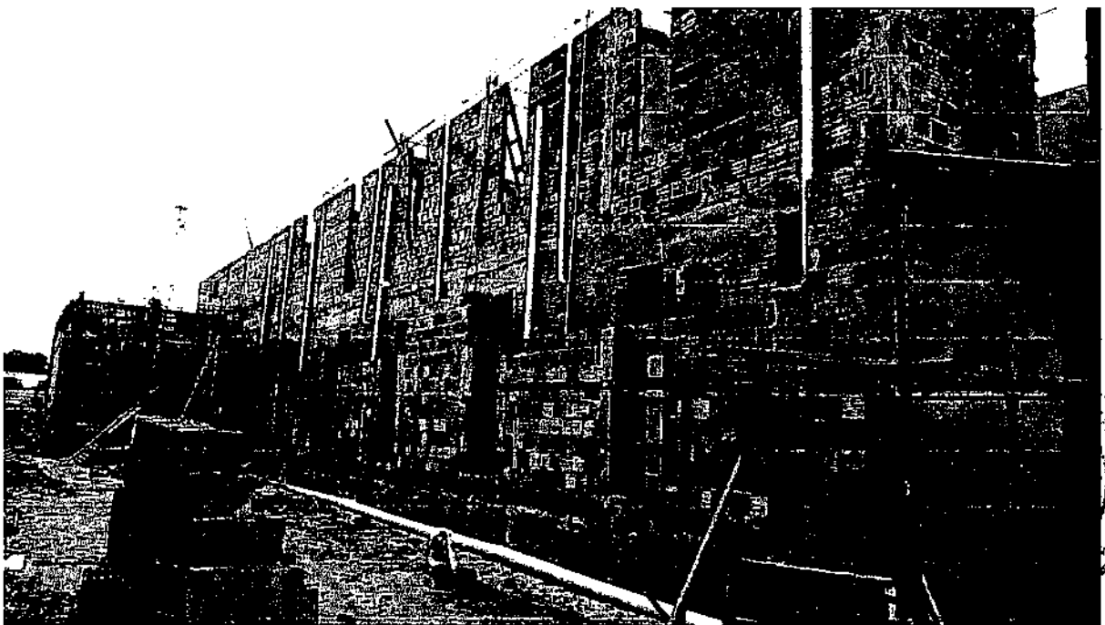
FOTO 99 - ALVENARIA DE VEDAÇÃO DE BLOCOS CERÂMICOS FURADOS NA HORIZONTAL DE 9X19X19 CM (ESPESSURA 9 CM) E ARGAMASSA DE ASSENTAMENTO COM PREPARO EM BETONEIRA. AF_12/2021
