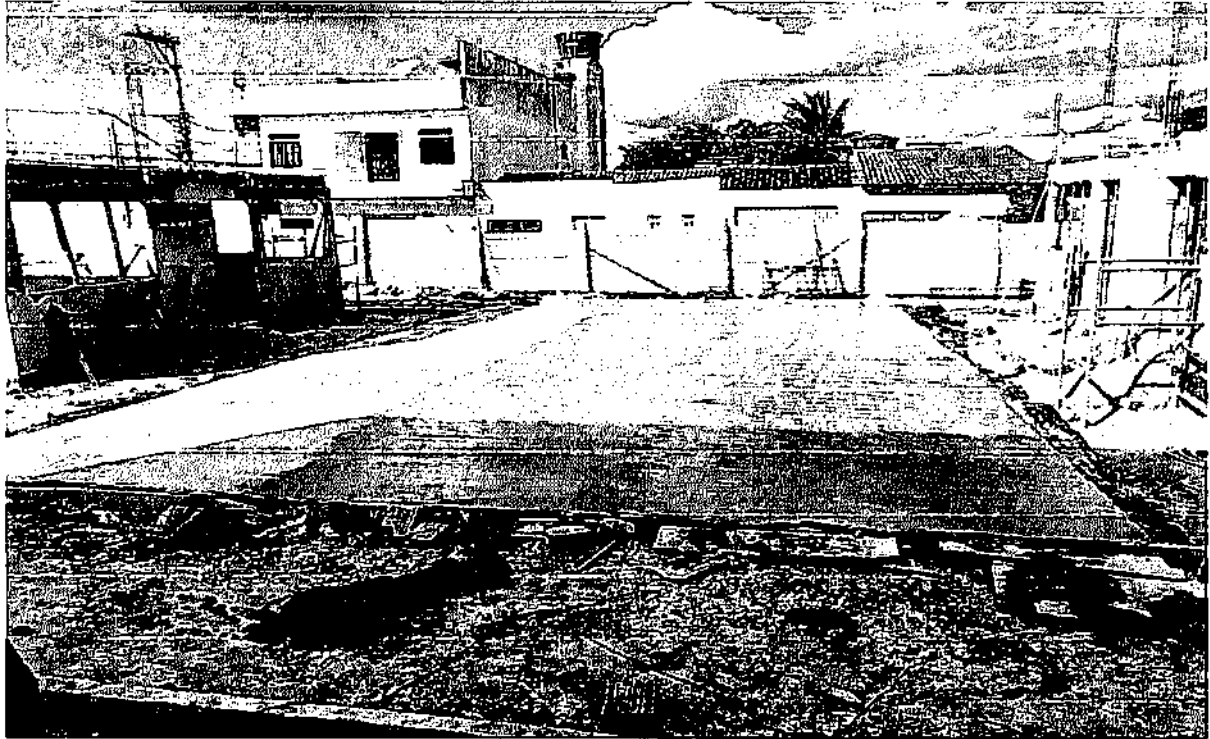
FOTO 93 - EXECUÇÃO DE PASSEIO (CALÇADA) OU PISO DE CONCRETO COM CONCRETO MOLDADO IN LOCO, FEITO EM OBRA, ACABAMENTO CONVENCIONAL, ESPESSURA 6 CM, ARMADO. AF_07/2016
