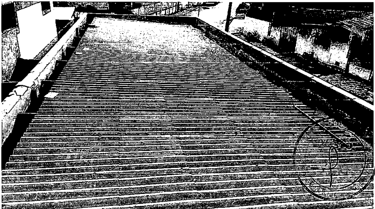
FOTO 55 - CALHA EM CHAPA DE AÇO GALVANIZADO NÚMERO 24, DESENVOLVIMENTO DE 50 CM, INCLUSO TRANSPORTE VERTICAL. AF_07/2019
