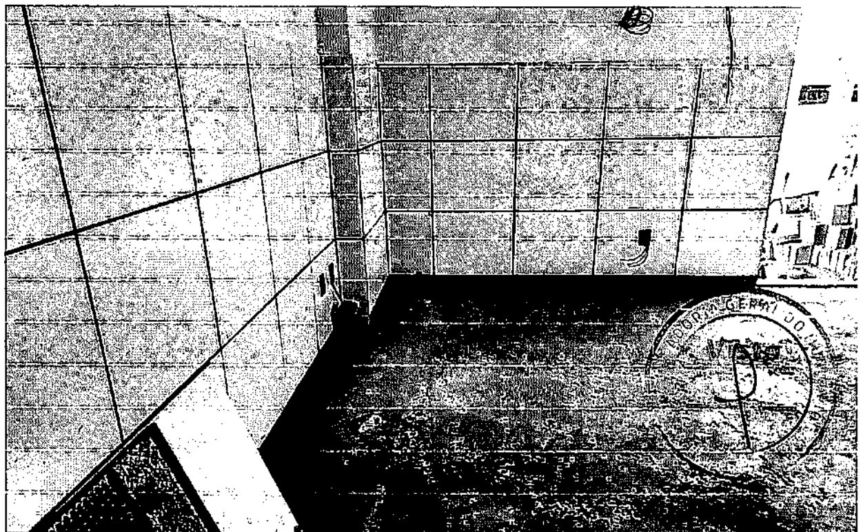
FOTO 18 - REVESTIMENTO CERÂMICO PARA PAREDES INTERNAS COM PLACAS TIPO ESMALTADA EXTRA DE DIMENSÕES 33X45 CM APLICADAS EM AMBIENTES DE ÁREA MAIOR QUE 5 M 2 NA ALTURA INTEIRA DAS PAREDES. AF_06/2014
