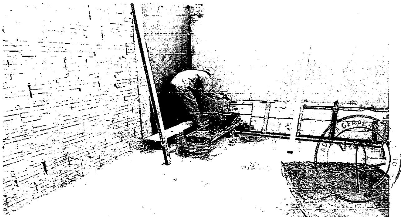
FOTO 12 - CHAPISCO APLICADO EM ALVENARIAS E ESTRUTURAS DE CONCRETO INTERNAS, COM COLHER DE PEDREIRO. ARGAMASSA TRAÇO 1:3 COM PREPARO EM BETONEIRA 400L. AF_06/2014
