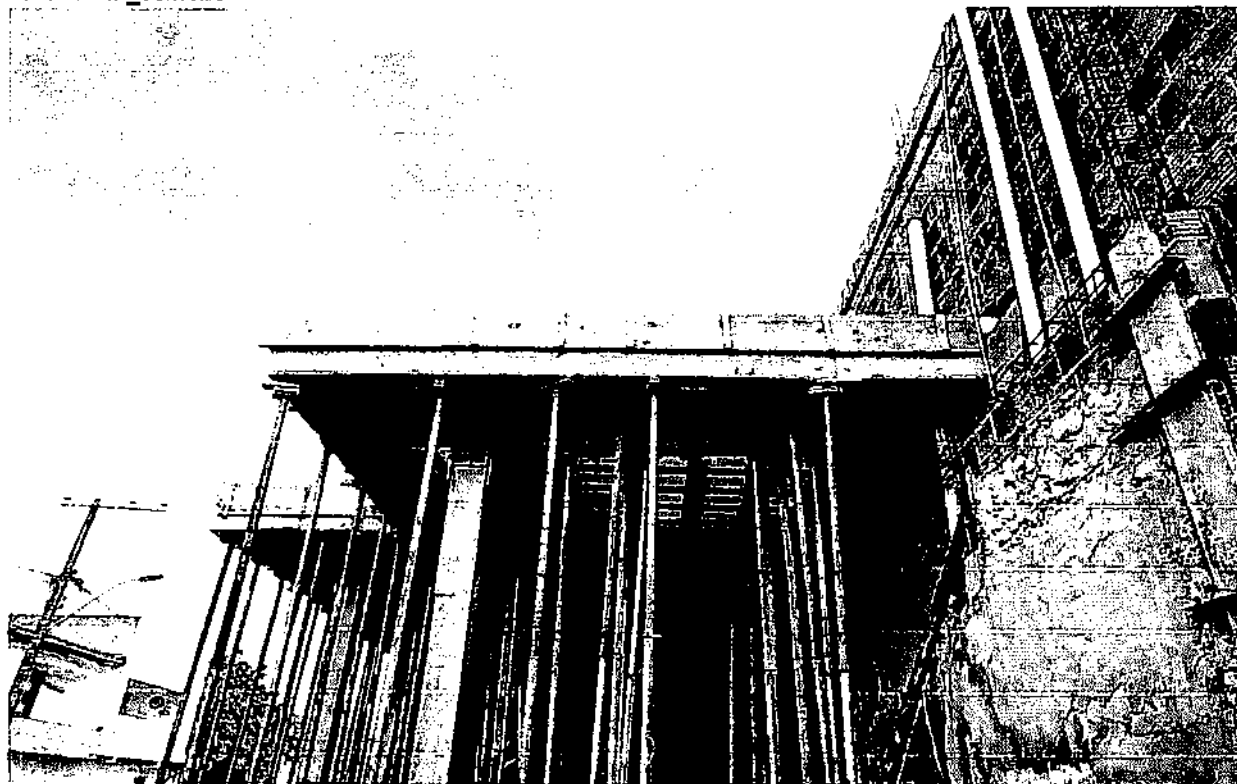
FOTO 10 - FABRICAÇÃO DE FÓRMA PARA LAJES, EM CHAPA DE MADEIRA COMPENSADA RESINADA, E = 17 MM. AF_09/2020
