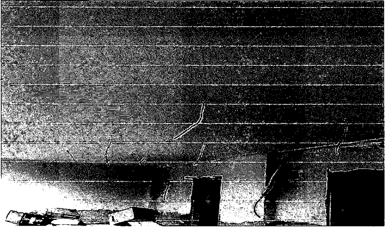
FOTO 47 - EMASSAMENTO COM MASSA A OLEO, DUAS DEMAS
