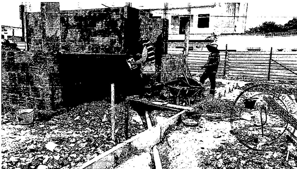
FOTO 65 - CHAPISCO APLICADO EM ALVENARIAS E ESTRUTURAS DE CONCRETO INTERNAS, COM COLHER DE PEDREIRO. ARGAMASSA TRAÇO 1:3 COM PREPARO EM BETONEIRA 400L. AF_06/2014
