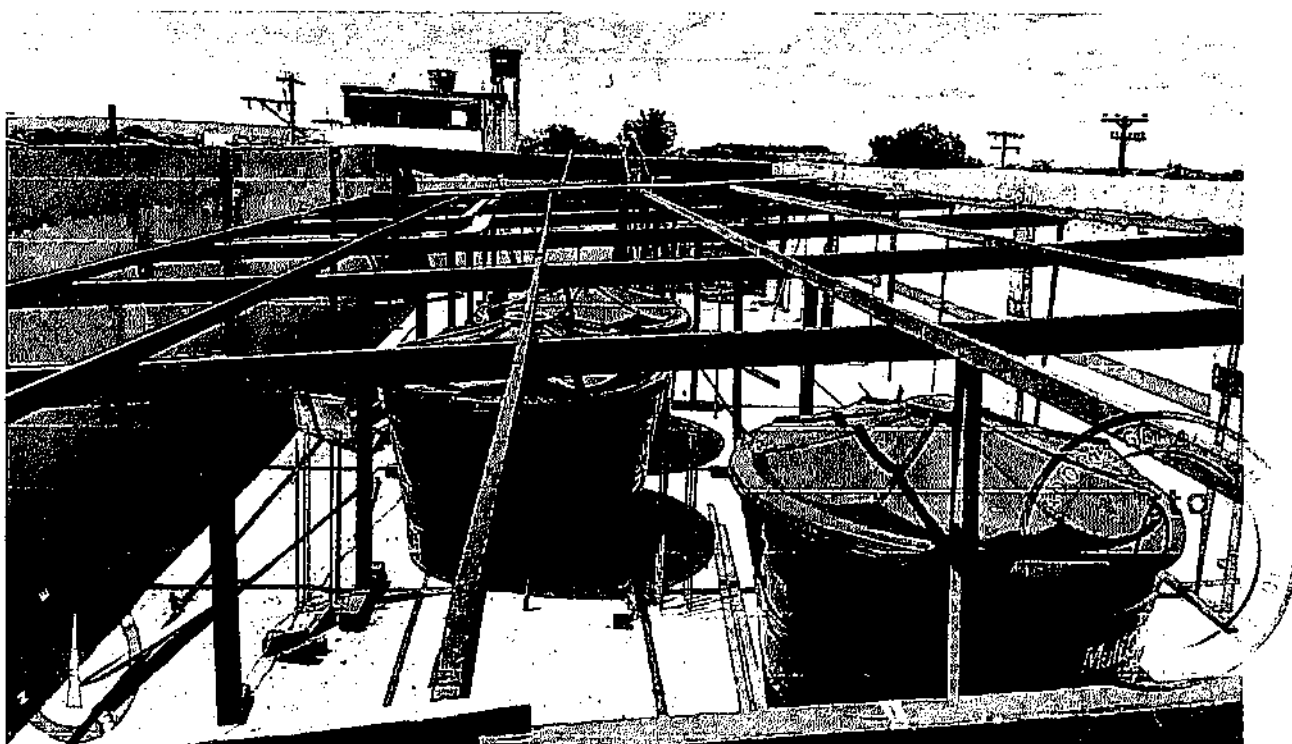
FOTO 77 - CAIXA D'ÁGUA EM POLIETILENO, 3000 LITROS (INCLUSOS TUBOS, CONEXÕES E TORNEIRA DE BÓIA) - FORNECIMENTO E INSTALAÇÃO. AF_06/2021
